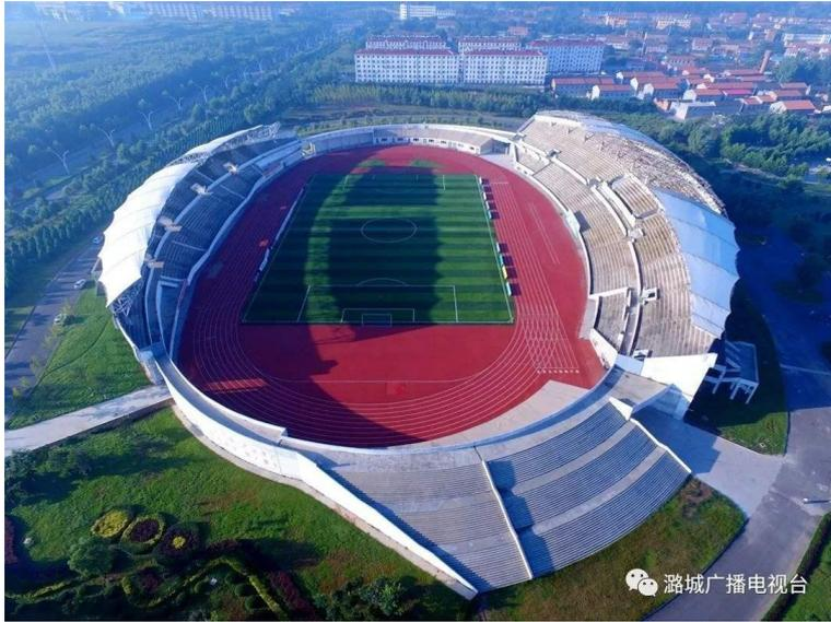
工程于 2006 年 10 月开工建设，体育场建筑面积 12996 平方米，总投资约 6000 万元，设有各类训练设施及附属用房等，建设规模为 12091 座位（固定座席），另可增加活动座席 2000 个。该工程总占地面积为 25730 m<sup>2</sup>，建筑面积为 12996 m<sup>2</sup>。工程东西看台为钢拉膜结构，总高度为 19.6 米，场地中央为 9000 平方米标准塑胶跑道和 8000 平方米人工草坪足球场。
